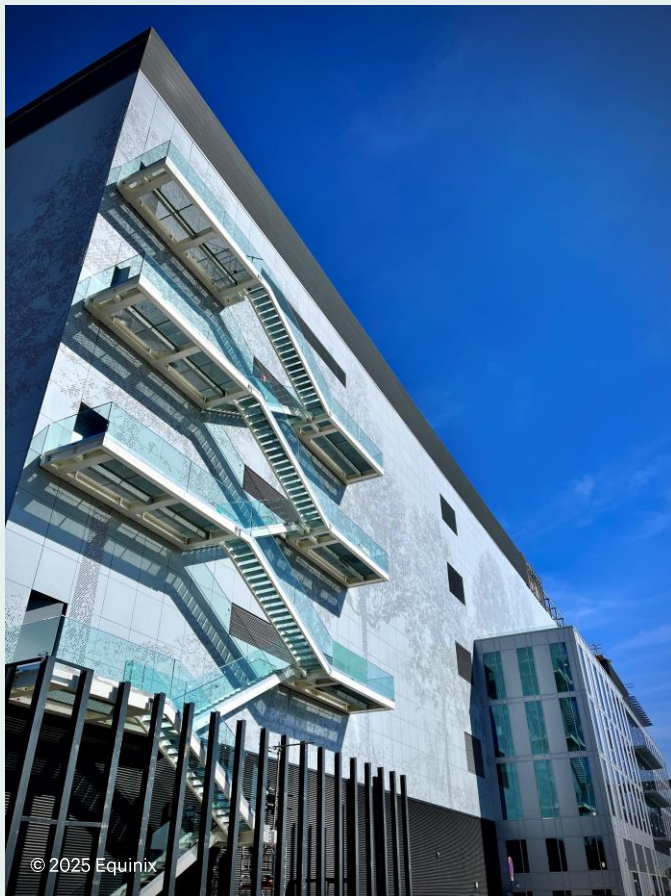
Le data centre PA13x d'une capacité de 14 MW a ouvert à Meudon fin 2023.
