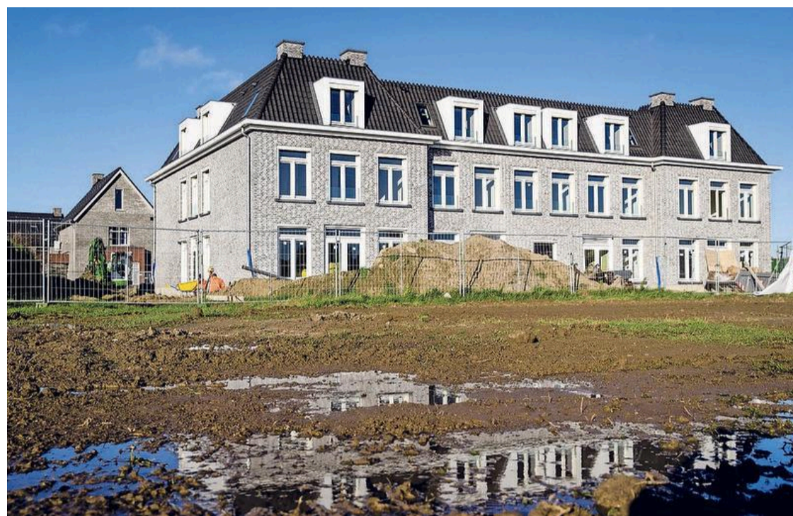
En complex met seniorenwoningen in aanbouw in het Limburgse Hertfen, dat onder de gemeente Roermond valt. FOTO ANP/HH
