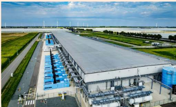
Google-datacenter in Middenmeer. Foto: Robin Utrecht/ANP
