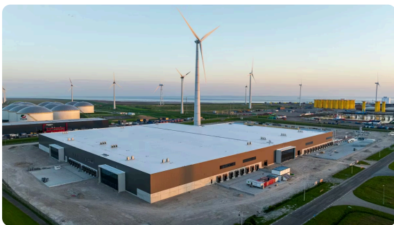
Het nieuwe distributiecentrum van CBRE staat te huur in de Eemshaven. Foto: Necron Group
