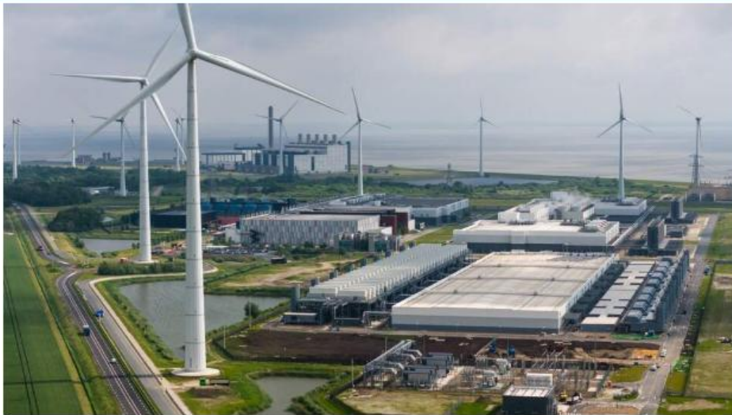
Datacenter van Google naast de Groningse Eemshaven. © ANP
